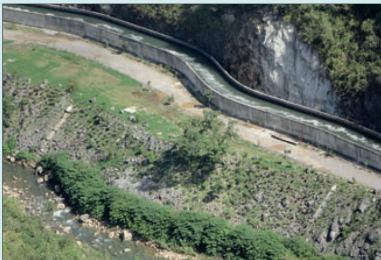
Barrage sur le fleuve Cahabón
